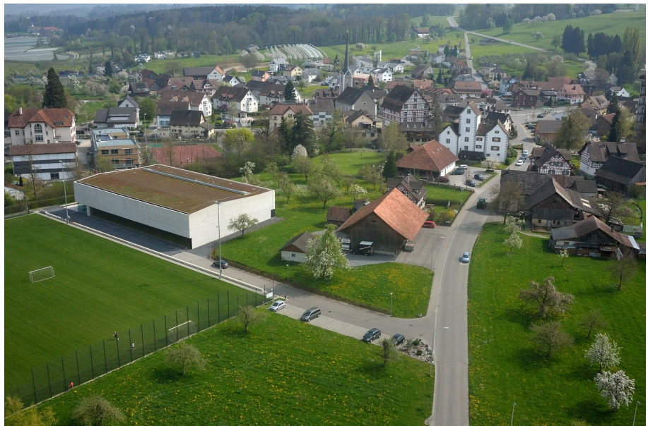
Luftaufnahme von Nordwesten (2014 / © Donald Kaden)
