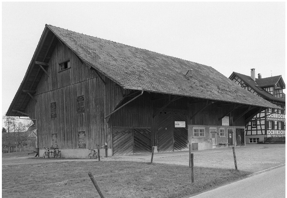
Scheune mit Wohnhaus (2004 / Amt für Denkmalpflege, Hinweisinventar Bauten)
